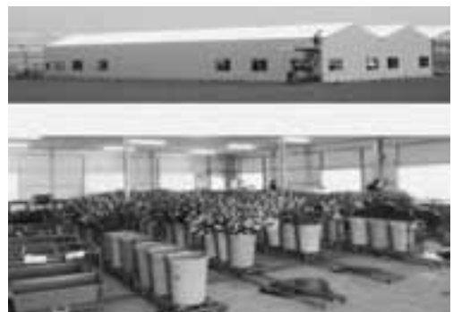
写真5 集荷場（600㎡）の外観と室内（調整室）
